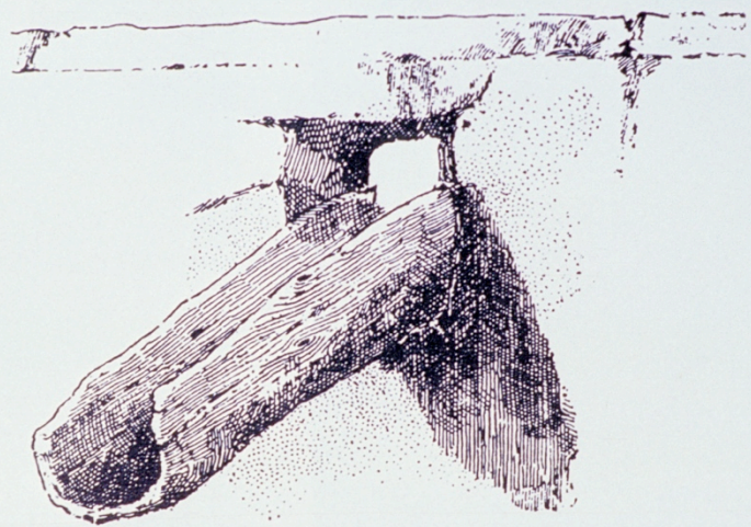
Canale (roof drain), Hopi
